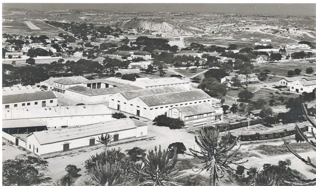
Instalações ferroviárias do CFAmboim. 1960
